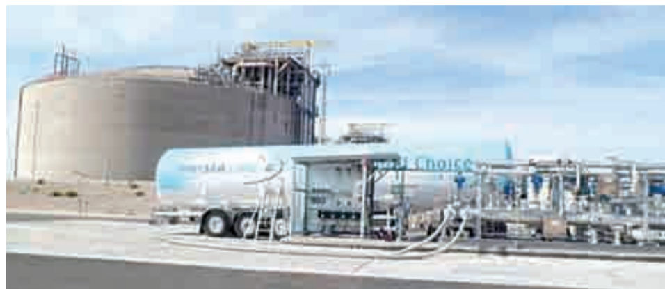
Τον Δεκέμβριο του 2021 θα είναι έτοιμος ο Σταθμός Φόρτωσης Βυτιοφόρων LNG του ΔΕΣΦΑ στη Ρεβυθούσα
